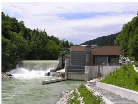
Kraftwerk Agonitz © Energie AG Oberösterreich
