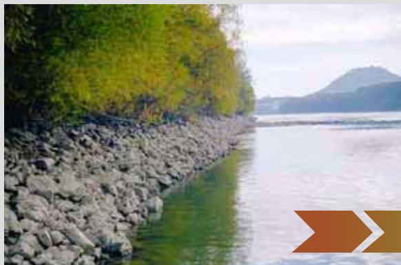
Pilot projekt Thurnhausen – ojačavanje obale prije izvođenja građevinskih radova
